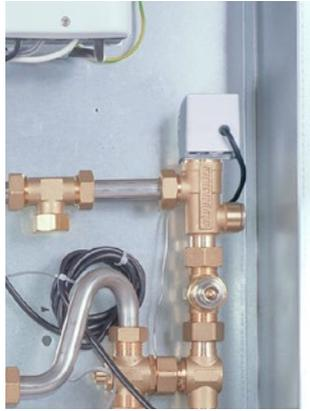
Bei Warmwasser-Zapfung wird der Heizkreis über das **step a valve** Ventil (17) im Controller abgeschaltet. Durch die Warmwasser-Vorrangschaltung reduziert sich der Gesamtvolumenstrom und kann kleinere Strangdimensionen ermöglichen.
