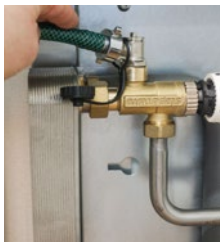
2. Füll- u. Entlüftungshähne leicht öffnen.
