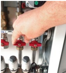
1. Kugelhähne schließen.
