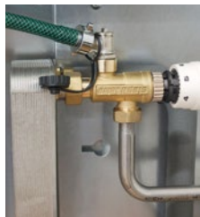
1. Kugelhähne schließen.
