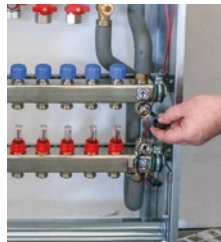
2. Füll- u. Entleerhähne leicht öffnen.
