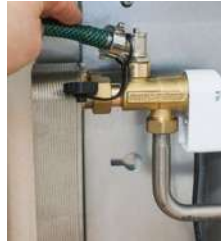
2. Füll- u. Entlüftungshähne leicht öffnen.
