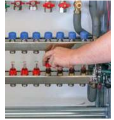
4. Plombierkappen abziehen und alle Durchflussmengenmesser öffnen.
