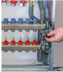
2. Füll- u. Entleerhähne leicht öffnen.
