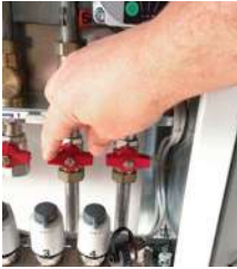
1. Kugelhähne schließen.
