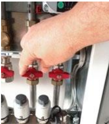
1. Kugelhähne schließen.
