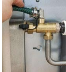
2. Füll- u. Entlüftungshähne leicht öffnen.
