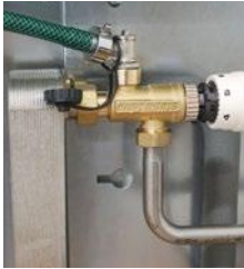
1. Kugelhähne schließen.
