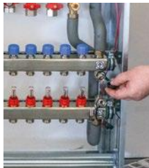
2. Füll- u. Entleerhähne leicht öffnen.
