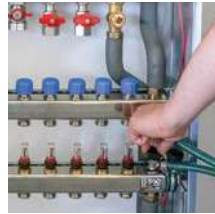
7. Wasserzulauf beenden. Füll- und Entleerhähne schließen. Schläuche abnehmen und die Kappen montieren.
