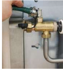
2. Füll- u. Entlüftungshähne leicht öffnen.
