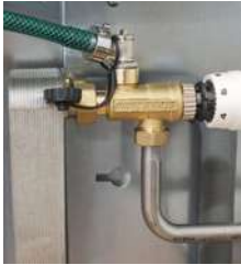
1. Kugelhähne schließen.
