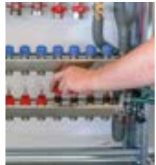
4. Plombierkappen abziehen und alle Durchflussmengenmesser öffnen.
