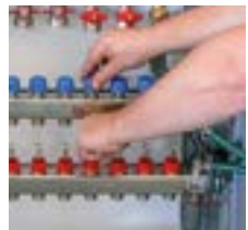
8. Alle Ventile und Durchflussmengenmesser öffnen. Plombierkappen montieren und die Kugelhähne öffnen.
