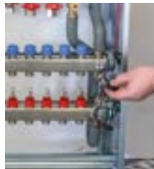
2. Füll- u. Entleerhähne leicht öffnen.
