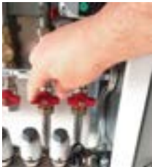
1. Kugelhähne schließen.
