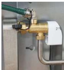
1. Kugelhähne schließen.
