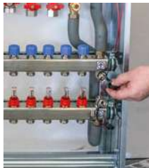
2. Füll- u. Entleerhähne leicht öffnen.
