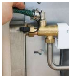
2. Füll- u. Entlüftungshähne leicht öffnen.
