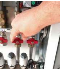
1. Kugelhähne schließen.
