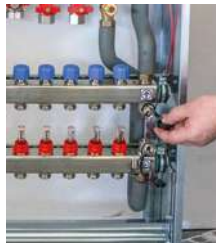
2. Füll- u. Entleerhähne leicht öffnen.
