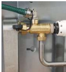
1. Kugelhähne schließen.
