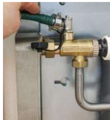
2. Füll- u. Entlüftungshähne leicht öffnen.
