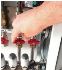
1. Kugelhähne schließen.
